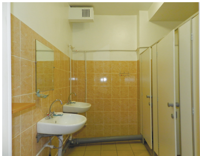
Обновленный санузел в цехе №301
