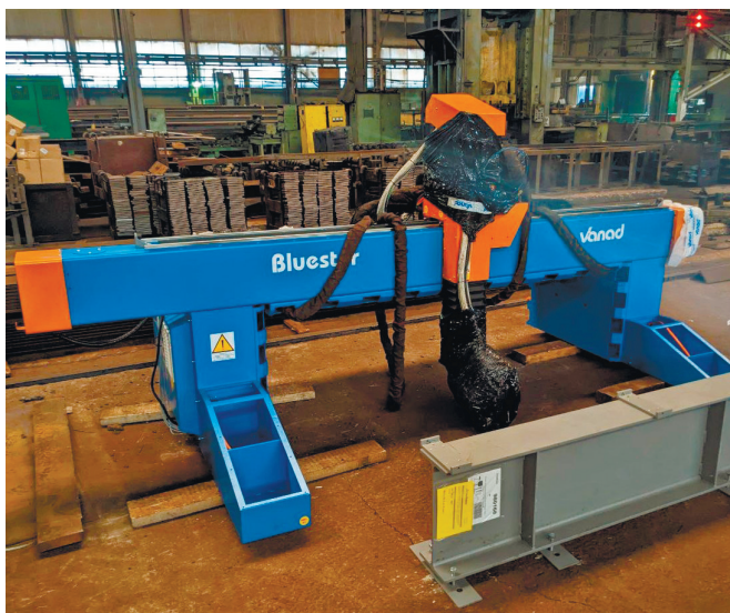
Монтаж машины плазменной резки
