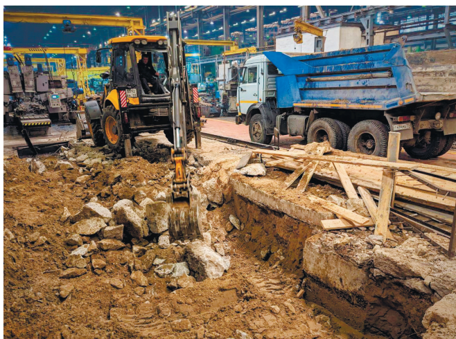
Подготовка к строительству фундамента
